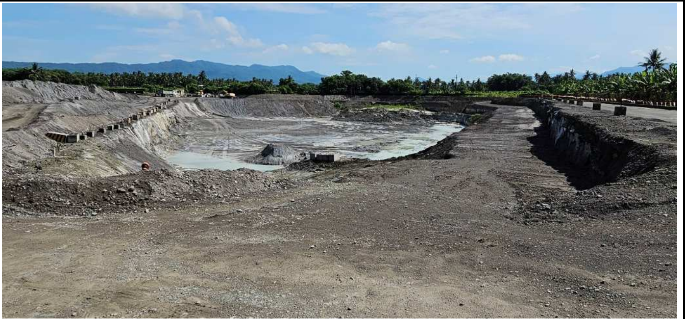
112 年 7 月底杜蘇芮颱風侵襲前工區狀況(尚可執行開挖作業)
